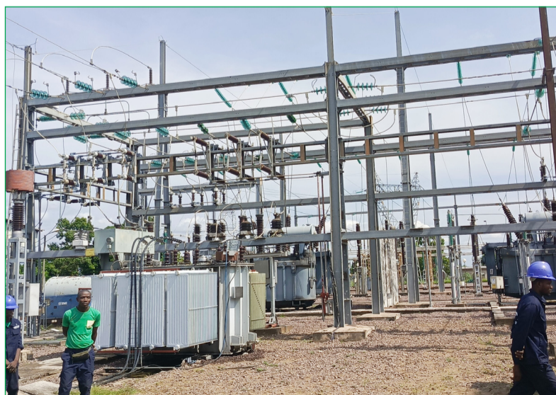
Un des chantiers pour améliorer la fourniture de l'électricité
